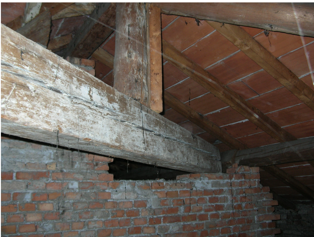
foto 8: traversa per il sostegno di travi colmo a tre vie.
