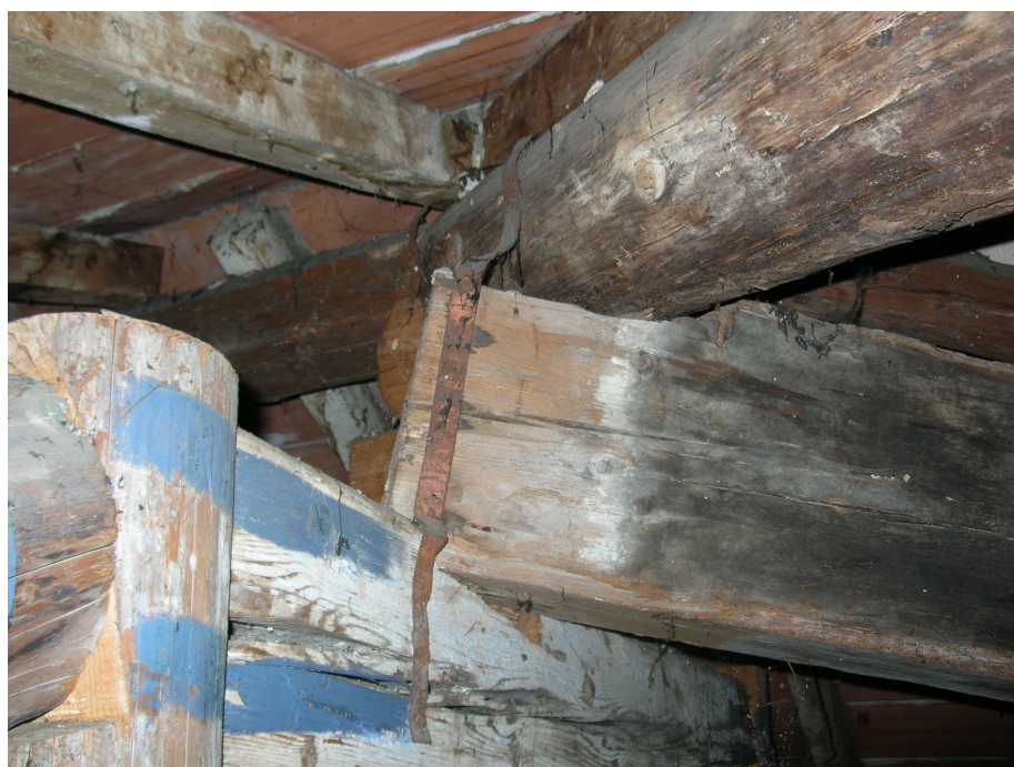
foto 4: travi e colmi in appoggio su capriata C2 / C3.
