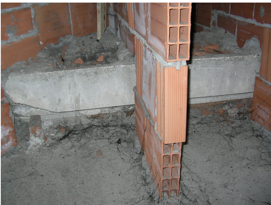
foto 12: lacerto della preesistente struttura di gronda in cemento.
