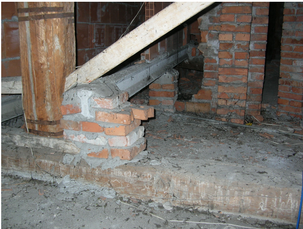
foto 11: trave in cemento, impropriamente appoggiata sulla catena della capriata C3 per sostenere una linea di muricci.
