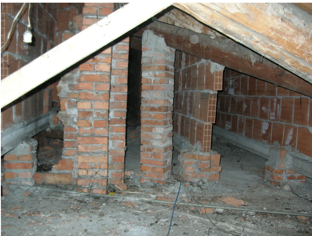
foto 10: raccordo con copertura a muricci e tavelloni.
