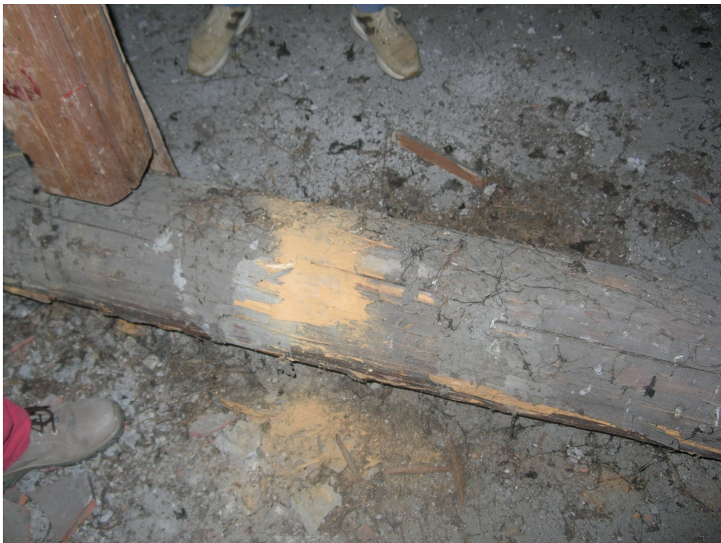
foto 7: Sfarinamento della catena della capriata 1 a causa di attacco da xilofagi.
