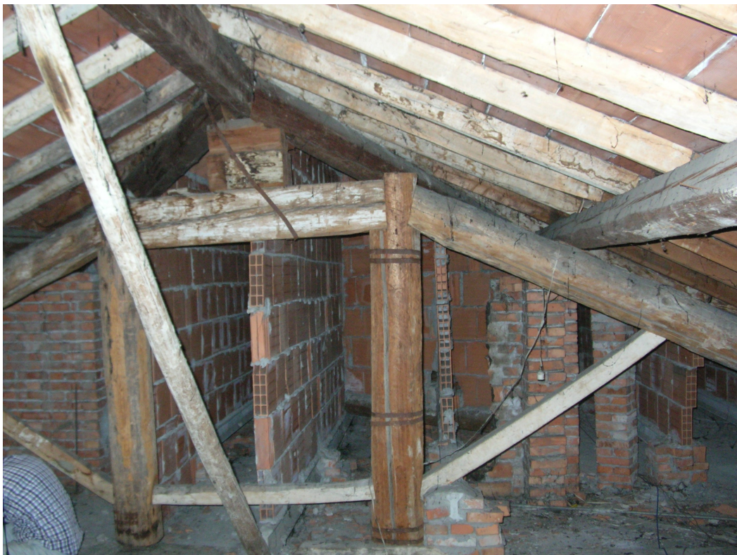
foto 9: capriata C3 e raccordo con copertura a muricci e tavelloni.
