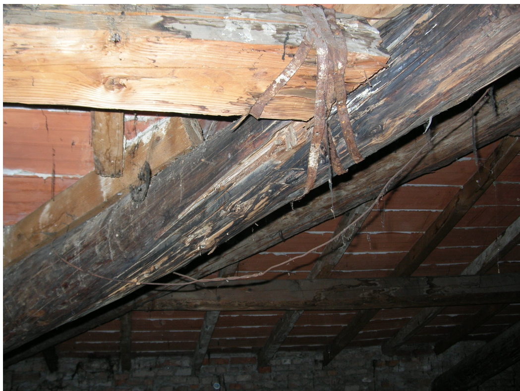
foto 1: diagonale lesionato con aggancio della terza mediante reggiatura.
