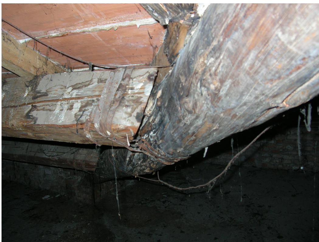
foto 2: Disassamento del diagonale nella zona lesionata
