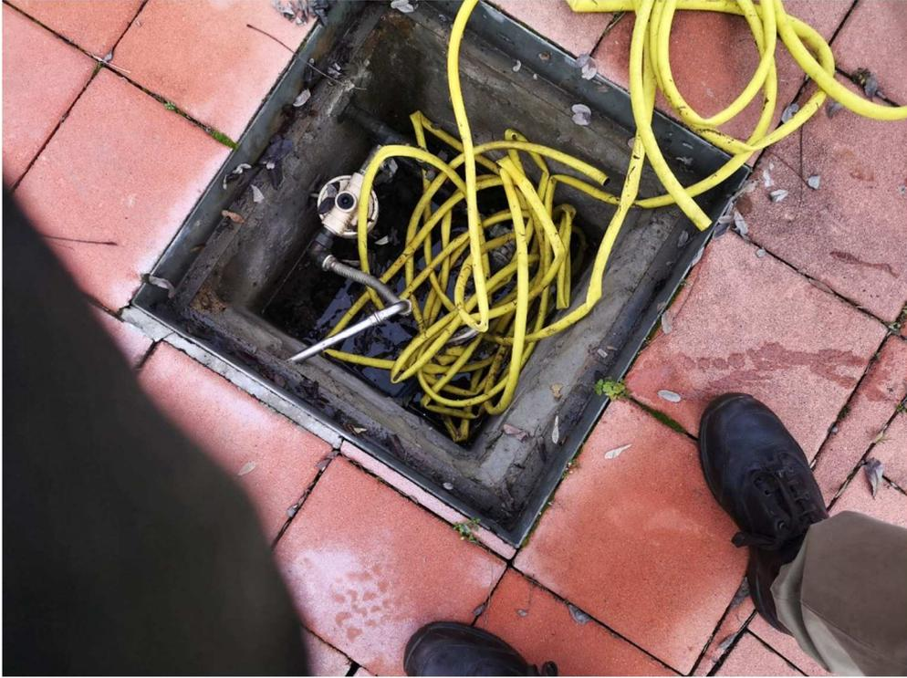
Vista 1.2 - Pozzetto in cui sostituire l'elettrovalvola delle docce
