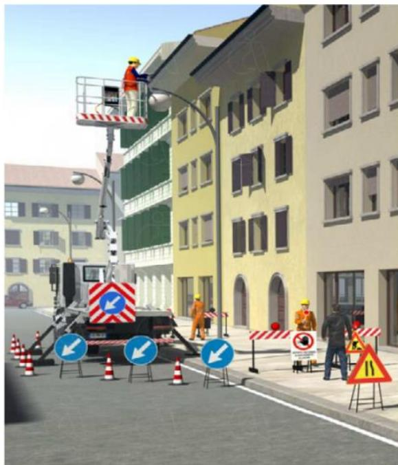
Il principio da seguire per la posa della segnaletica a cura di **preposto** e **lavoratori** che siano **formati sull'uso della segnaletica** e che risultino dotato di DPI di categoria II è il seguente, basato sulla larghezza di corsia "residua" oltre la zona di lavoro e basato sull'entità del traffico. Questi fattori possono essere variabili in relazione al tipo di attrezzatura, larghezza di stabilizzazione, tipo stabilizzatori, ora e periodo d'intervento.
